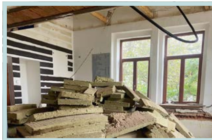
Stav interiéru před rekonstrukcí.
